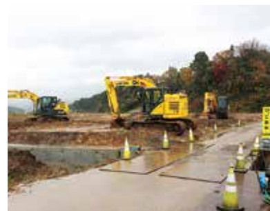
基盤整備の工事中(布施爪地区)
